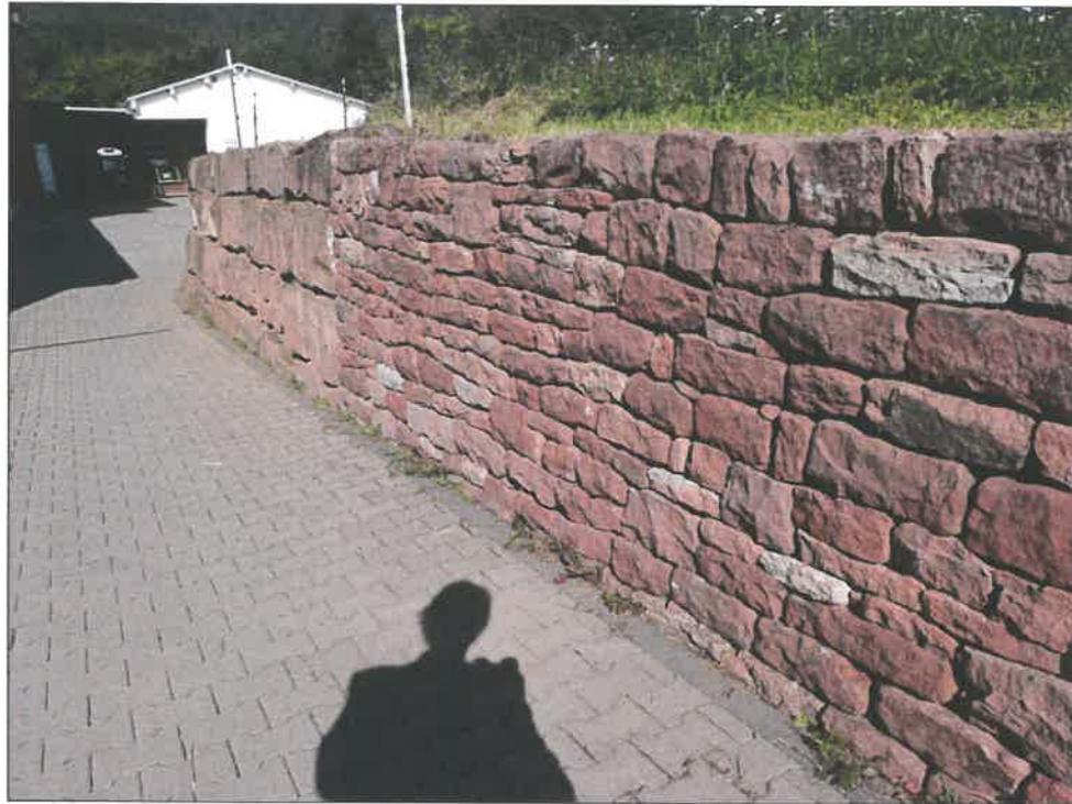
Abb. 5: Südrand des Baugrundstückes mit Blocksatz im Westen und Trockenmauer (mit Beton hinterfüllt, kein Kontakt zum anstehenden Boden) (09.08.2017)
